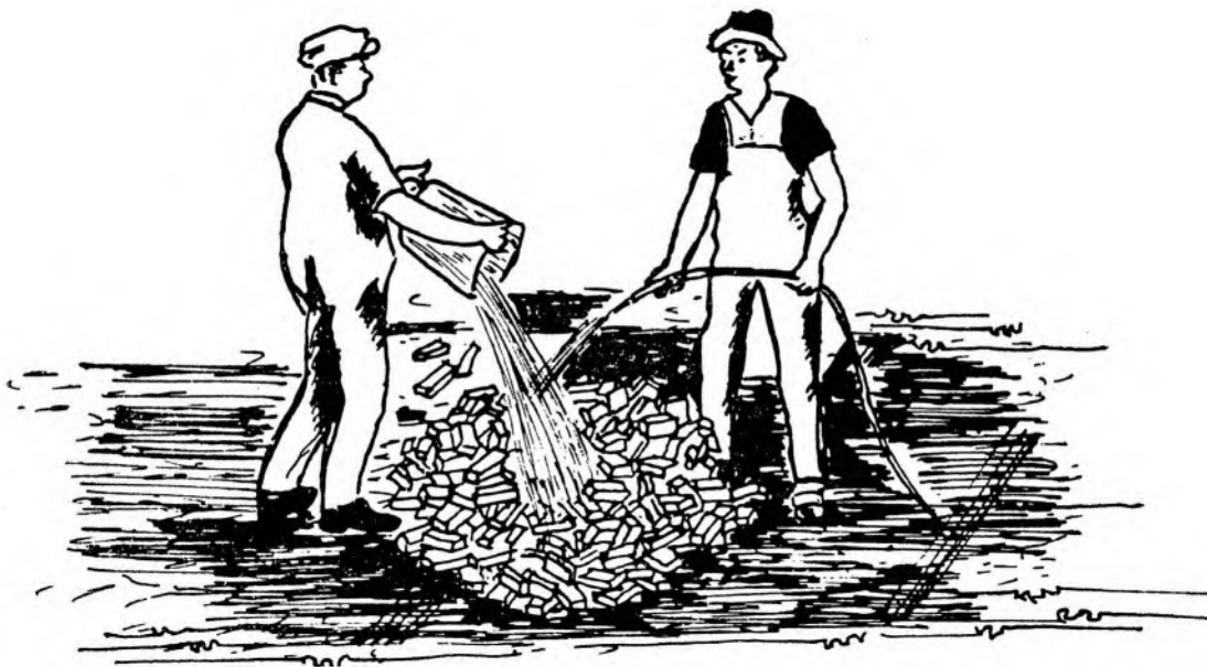
شکل ۳۷ ▲ زنجاب کردن آجر
