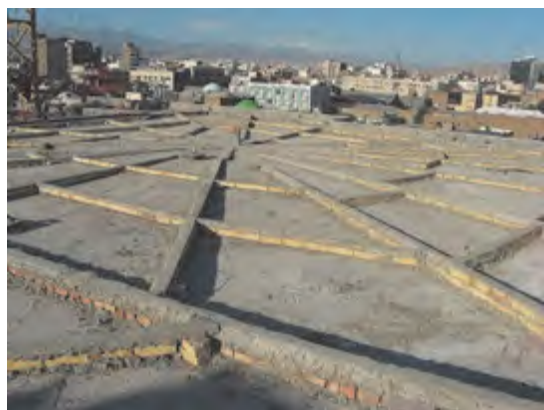
شکل ۱۴ ▲ کرم‌بندی و شمشه‌گیری بین آن‌ها
