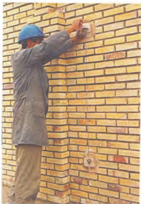
▲ شکل ۲۰ شاقولی کردن کرم‌ها
