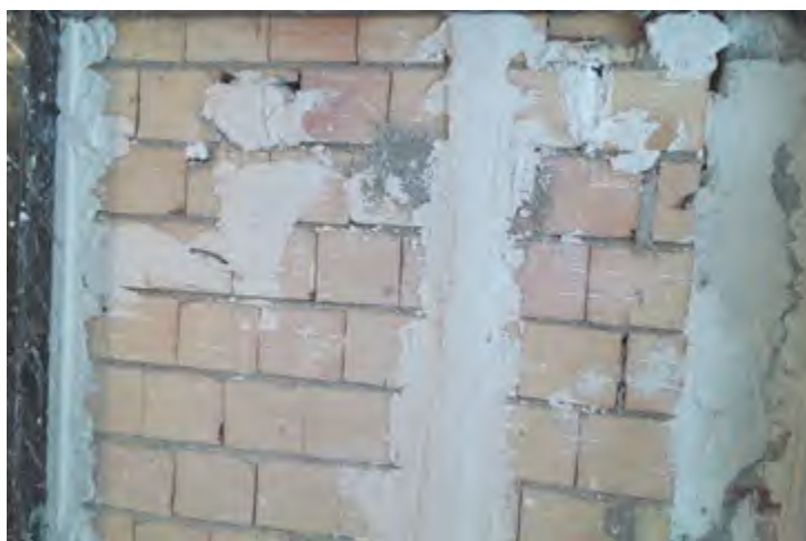
شکل ۲۴ ▲ شمشه گیری بین کرم ها
