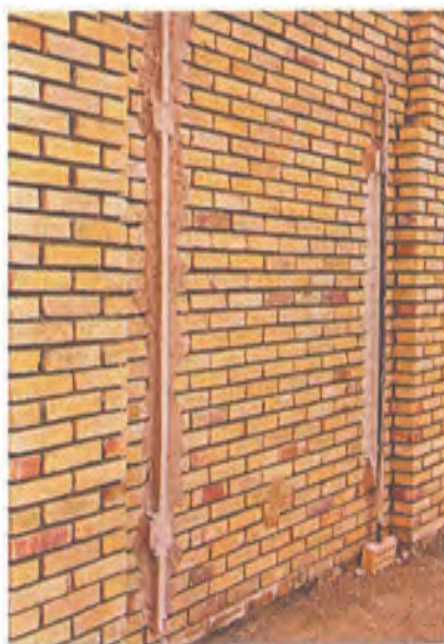
شکل ۲۳ ▲ شمشه گیری بین کرم ها
