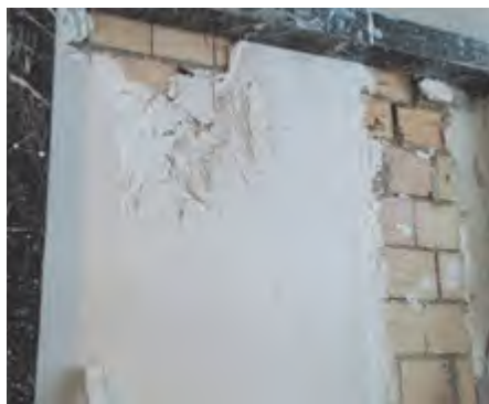
شکل ۲۵ ▲ پر کردن متن بین شمشه‌ها
