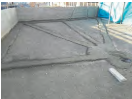
شکل ۱۴ ▲ کرم‌بندی و شمشه‌گیری بین آن‌ها
